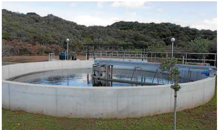
El decantador permite separar el agua clara de los fangos residuales. ● FOTO KARLOS HURTADO
